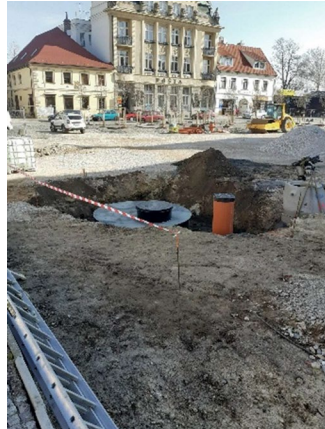
Mnichovo Hradiste (CZ) - Regenwassersensible Gestaltung und Umsetzung von Baumrigolen auf vollversiegelten Marktplatz
