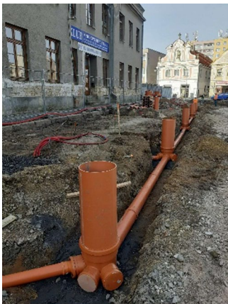
Mnichovo Hradiste (CZ) - Regenwassersensible Gestaltung und Umsetzung von Baumrigolen auf vollversiegelten Marktplatz
