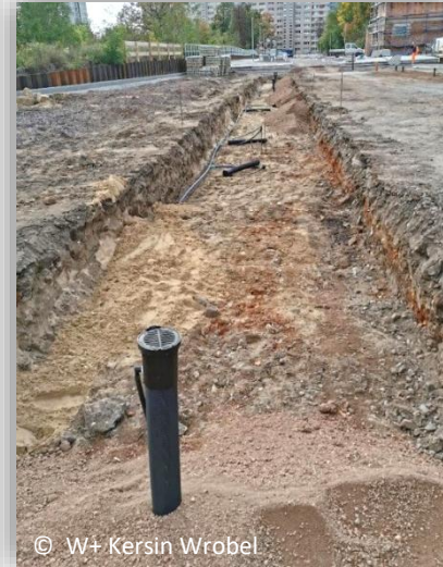
Einbau der Baumbewässerung Sommer 2022
