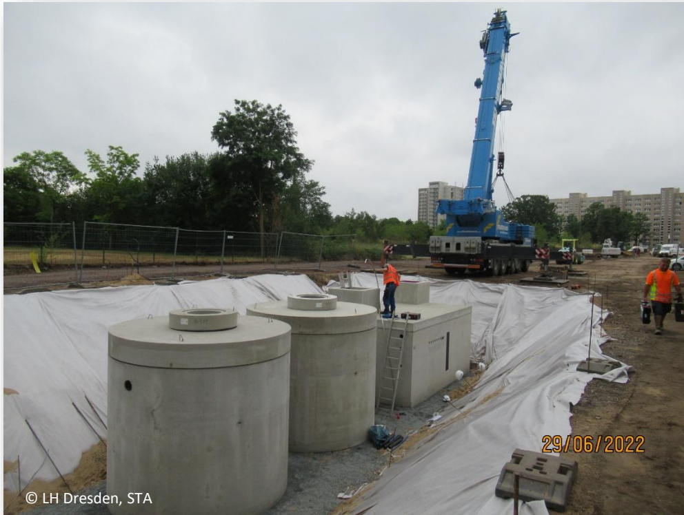
Einbau der Zisternen und des Brunnenschachtes Sommer 2022
