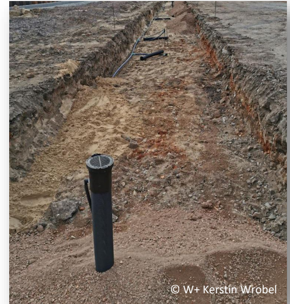
Einbau der Zisternen und des Brunnenschachtes sowie der Baumbewässerung Sommer 2022
