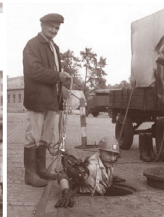
► Kanalarbeiten – mit Seilsicherung (!), 1968/69
