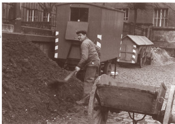
▲ Kanalarbeiter Siegfried Naumann mit Schlammkarren sowie Aufenthalts- und Gerätewagen, 1968
