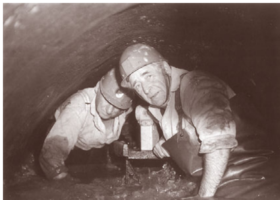
▲ Kanalreinigungsarbeiten im Neustädter Abfangkanal – wenig Luft nach oben wegen hoher Ablagerungen, 1980er Jahre
