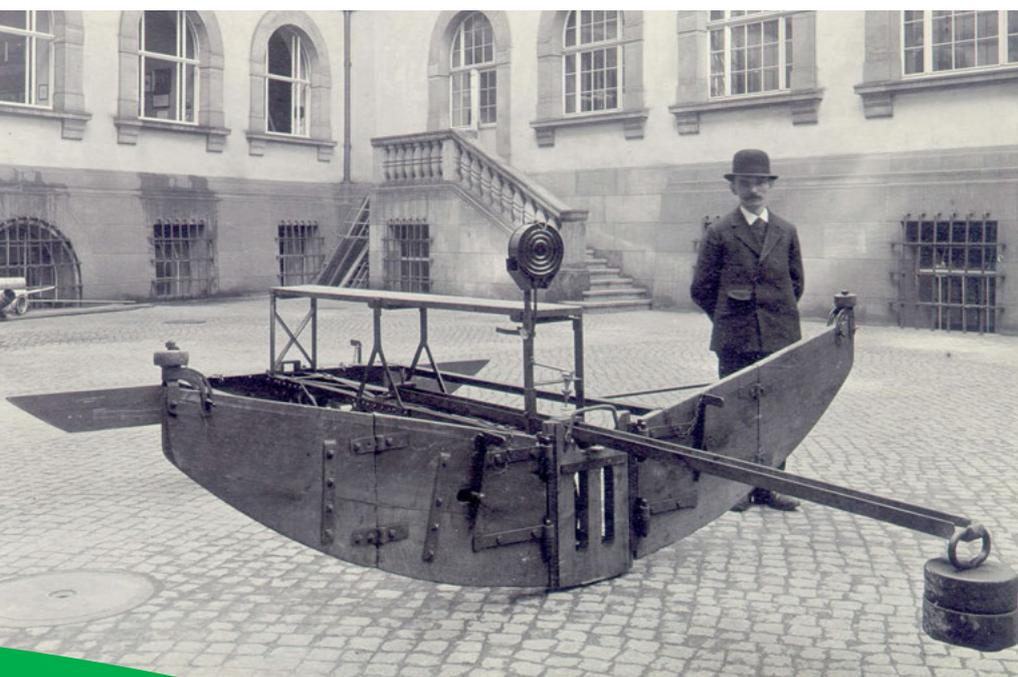
Abb. 1: Reinigungswagen für Abfangkanäle, 1912
