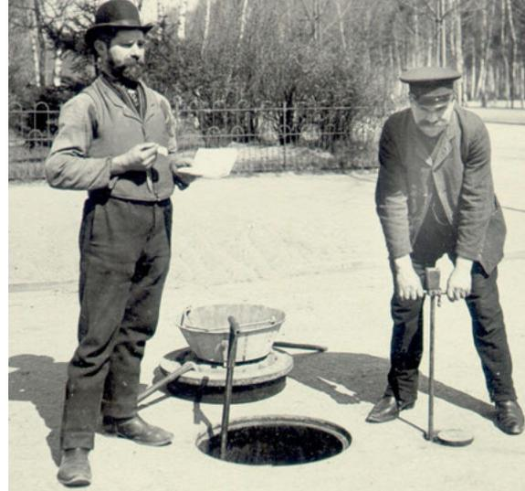
Abb. 3: Füllen eines Endschachtes mit Trinkwasser zur Kanalspülung einschließlich Dokumentation im Betriebsbuch, 1911
