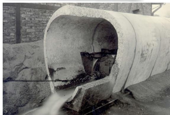
Abb. 4: Reinigungsgeräte für kleine und mittlere Kanäle mit Spülstrahlusbildung im Sohlbereich, 1911
