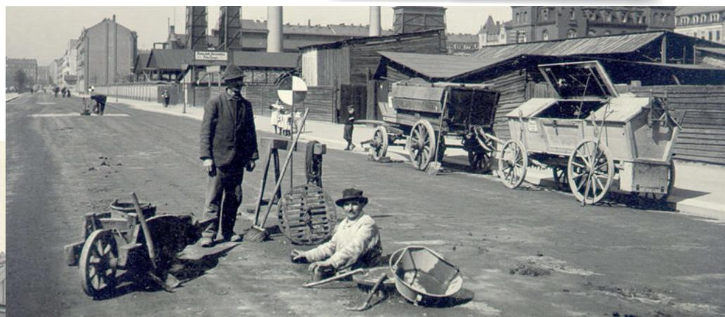
Abb. 5: Kanalreinigung auf dem Tatzberg in Richtung Bönischplatz, seitlich abgestellt sind Geräte- und Schlammtransportwagen, 1911
