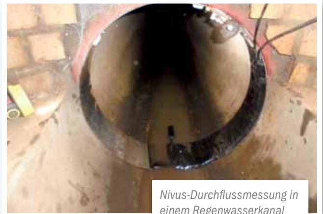
Nivus-Durchflussmessung in einem Regenwasserkanal
