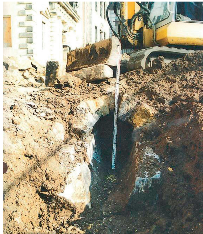
Der alte Schloßstraßenkanal von 1868 DN 850/1500 aus Sandstein mit nur 60–70 cm Überdeckung (Ausgrabungsfoto)
