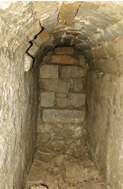
▲ Das abgemauerte Ende des Kanals 700/1840 im Bereich der Schinkelwache im Jahre 2017 (Foto: SEDD)
