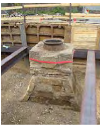
Bei den Bauarbeiten 2012 teilweise freigelegter Schacht der alten Kanalisation auf dem Schillerplatz
