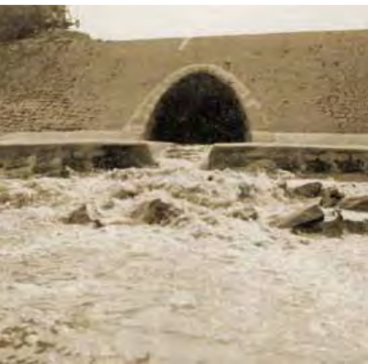
Oben: Kreuzung des Weißeritzmühlgrabens mit dem Abfangkanal
