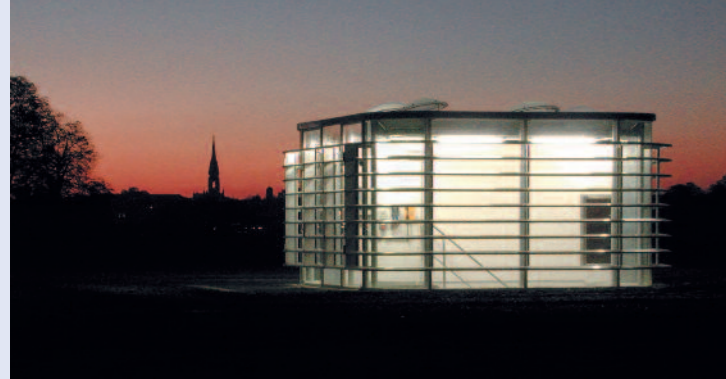
Einstieg zum Regenüberlaufbecken in Dresden-Johannstadt
