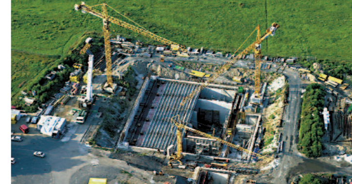
Fünf unterirdische Kammern können bei Regen 12.000 Kubikmeter Mischwasser speichern. Foto aus der Bauphase im Jahr 2000.
