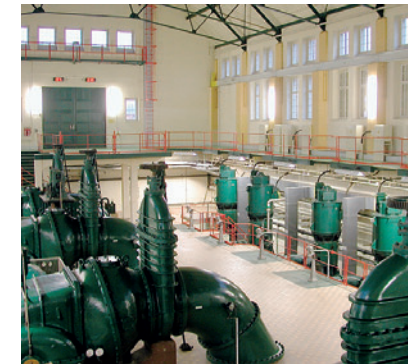
links: historische Regenwetterpumpen rechts: moderne Schmutzwasserpumpen
