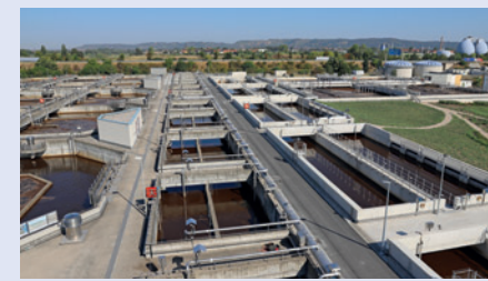
Blick auf die neuen Behandlungsbecken der biologischen Reinigung
