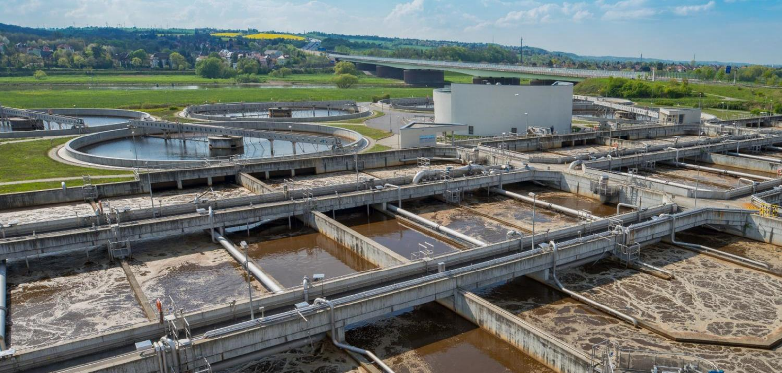
Abb. 34: Belebungsbecken und Nachklärbecken der Kläranlage Dresden-Kaditz
