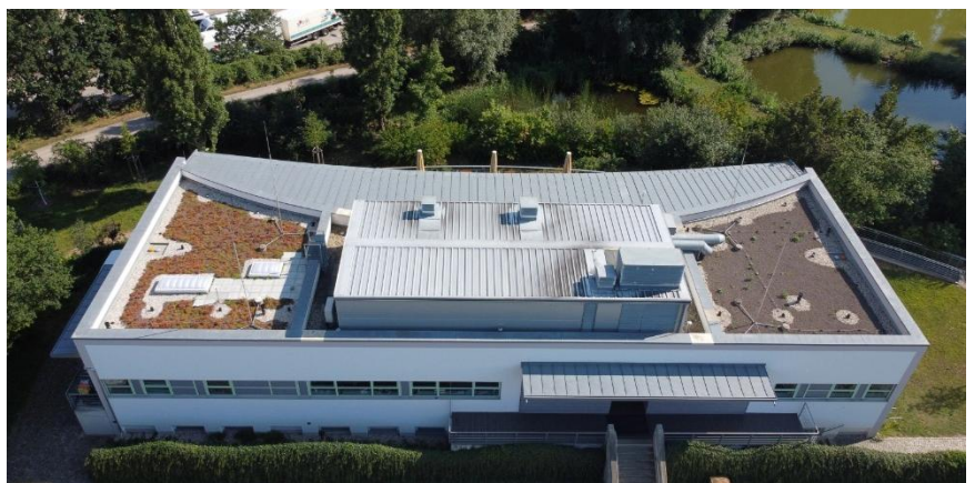
Abb. 54: Beispiel Dachbegrünung auf der Kläranlage Dresden-Kaditz
