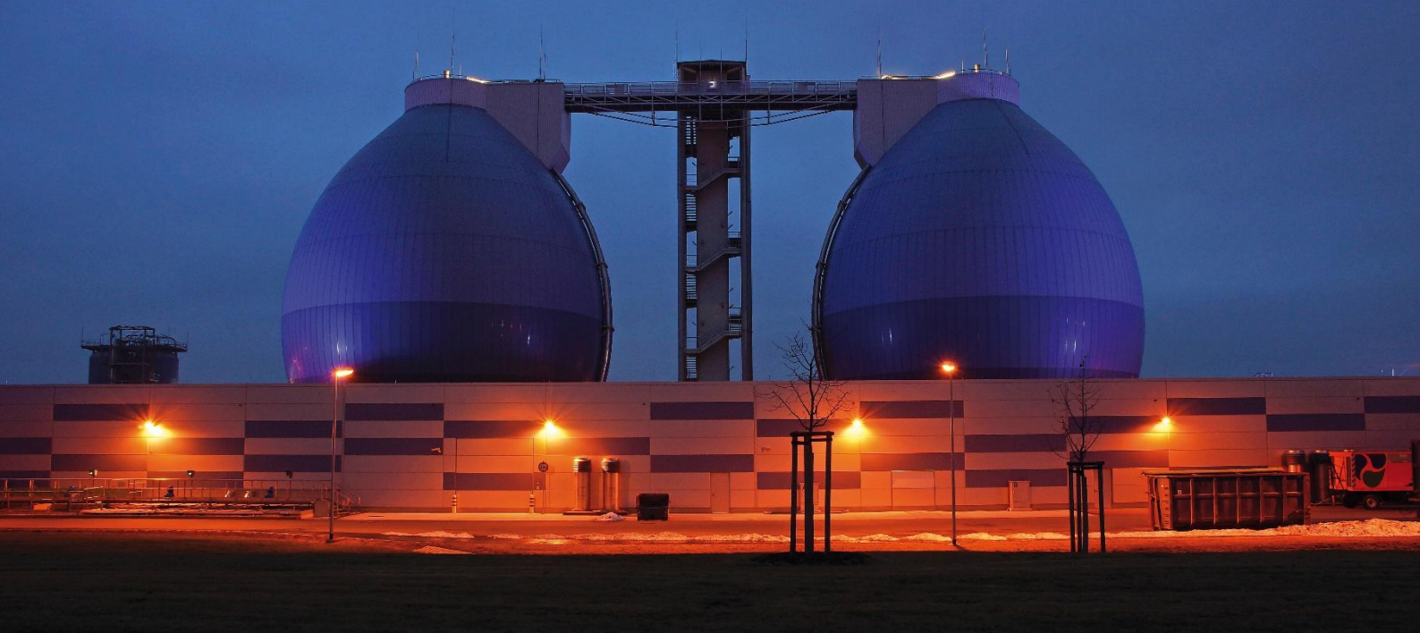
Abb. 8: Faultürme bei Nacht auf der Kläranlage Dresden-Kaditz
