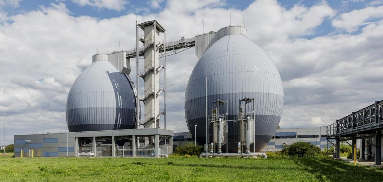
Abb. 31: Faultürme der Kläranlage Dresden-Kaditz
