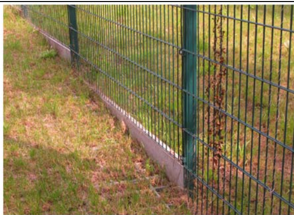
Abbildung 6: Umzäunung im hängigen Bereich (unterer Abschluss mit Rasenkantenstein)
