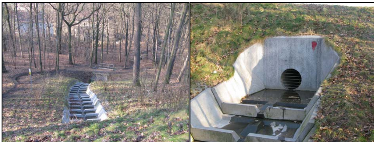
Abbildung 4: Beispiel für Kaskadenausbildung bei höher liegenden Beckenzuläufen
