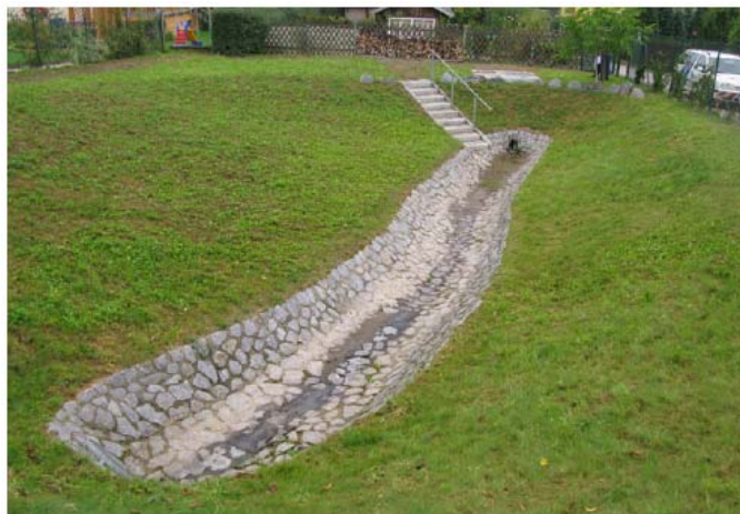
Abbildung 2: Beispiel für Rinne zwischen Ein- und Auslauf bei einem RRB
