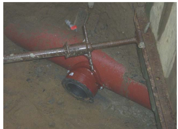
Sattelstück am Gussrohr (Saint Gobain)
