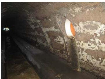
falsche Einbindehöhe
