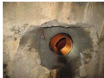
Einbindung mit Zerstörung des HK
