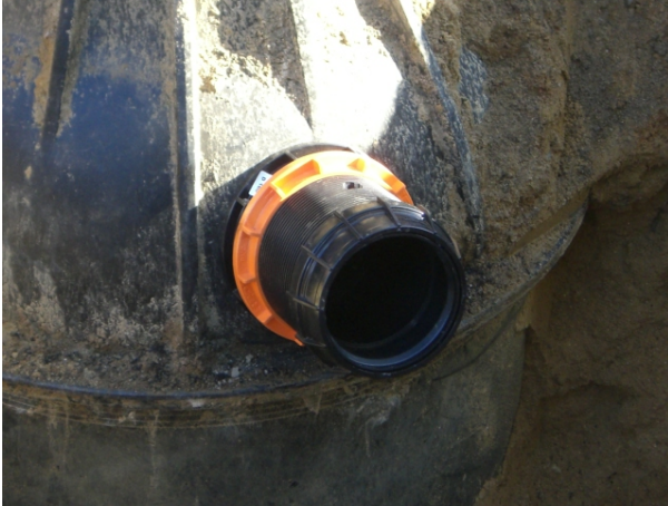
Anbindung an Kunststoffschacht
