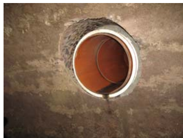
undichte Rohrführung
