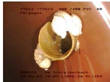
einragend, falsches Material
