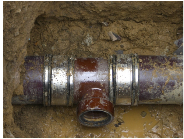
Formstück aus Stz incl. Canada-Manschetten
