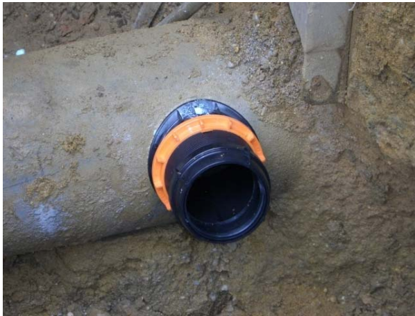
fachgerechte Anbindung mittels Stutzen
