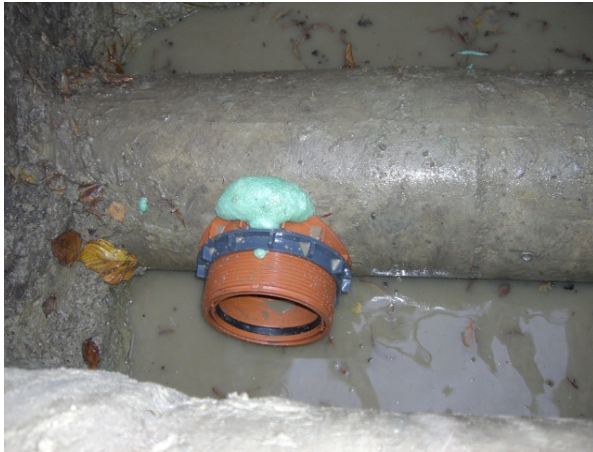
Stutzen mit Versiegelung der angebohrten Bewehrung
