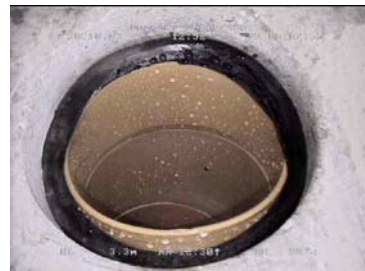
Dichtungsgummi gequetscht
