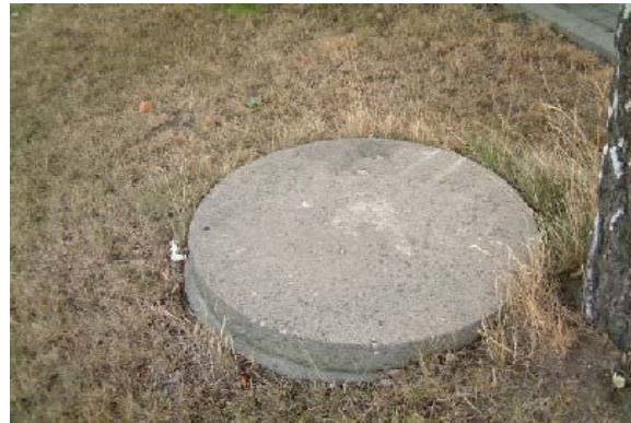
A 15 Abdeckung Betondeckel, Deckeldurchmesser 95 cm → Bauhöhe 8 cm
