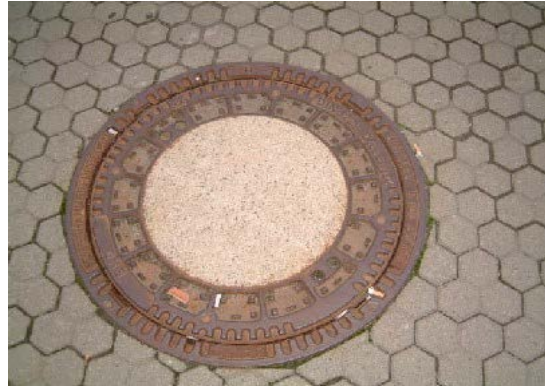
Bild D 6b: ohne Lüftung
