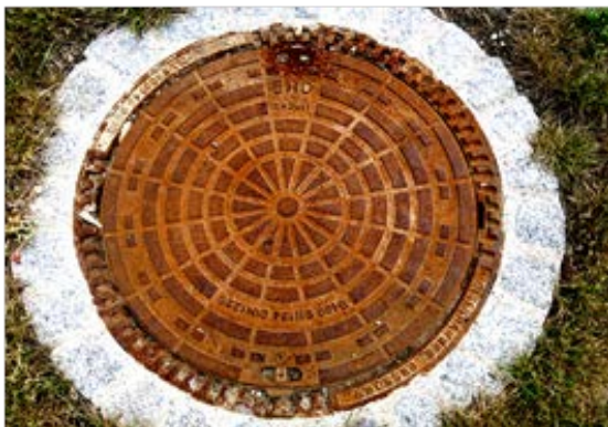
Bild D 53: ohne Lüftung
