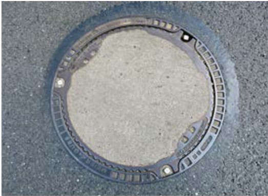
D 400 Abdeckung BEGU verschraubt, tagwasserdicht → Bauhöhe 16 cm
