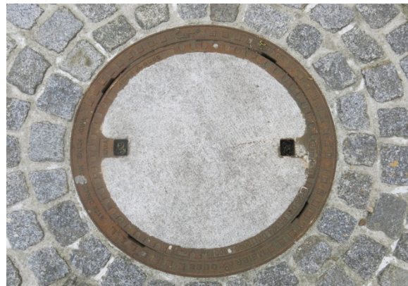
B 125 BEGU-Abdeckung → Bauhöhe 12,5 cm
