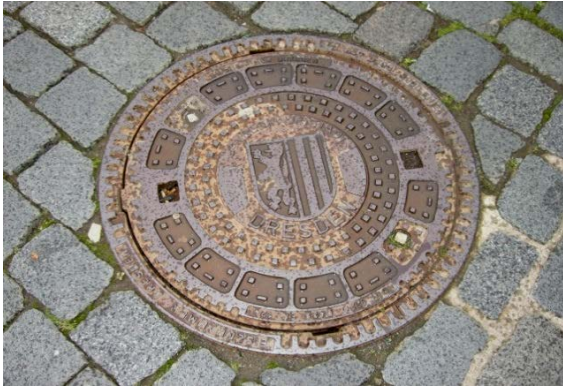
D 400 Abdeckung (tagwasserdicht) BEGU Rahmen, Deckel aus Guss, verschraubt → Bauhöhe 16 cm
