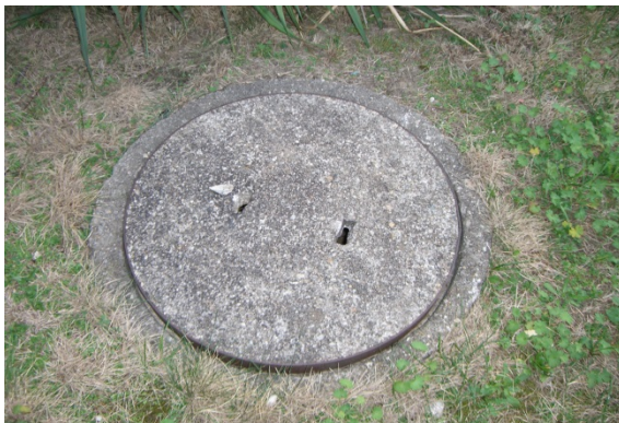
A 15 Abdeckung Betondeckel mit Eisenrad und Betonhülse, Deckeldurchmesser 67 cm → Bauhöhe 15 cm
