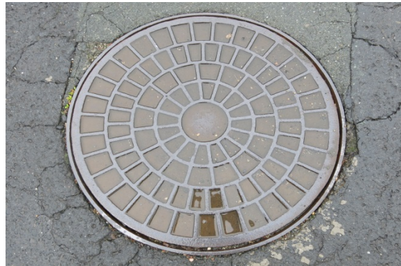
A 15 Abdeckung Vollguss, Deckeldurchmesser 68 cm → Bauhöhe 8 cm
