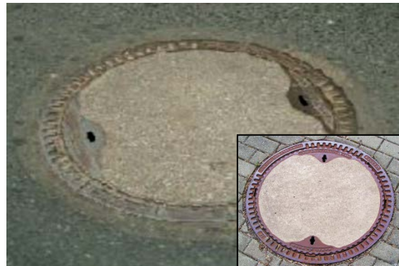
Bild D 6f: ohne Lüftung
