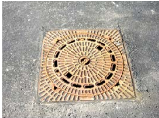
D400 Abdeckung quadratisch Vollguss Multitop (Aco) → Bauhöhe 15 cm
