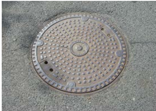
D 400 Abdeckung (Berliner) Vollguss ohne Lüftung → Bauhöhe 11 cm
