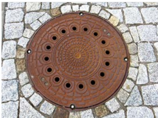
D 400 Abdeckung, verschraubt, DN 800 (MeierGuss)
