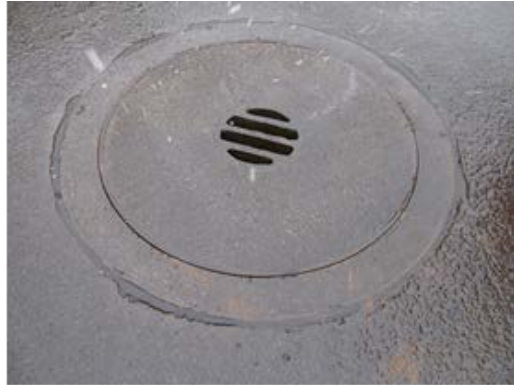
D 400 Flüsterabdeckung einwalzbar 1. Version EHD (eingestellt) → Bauhöhe 22 cm
