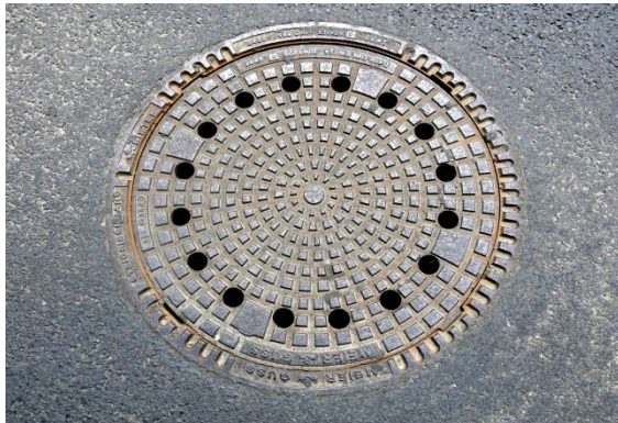
D 400 Abdeckung Vollguss → Bauhöhe 16 cm
