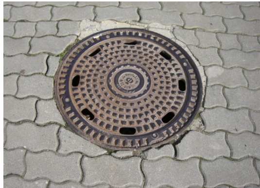
400 Abdeckung (Berliner) Vollguss, Deckeldurchmesser 66 cm → Bauhöhe 11 cm
