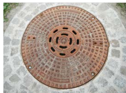
D 400 Abdeckung, verschraubt, DN 800 (MeierGuss)
