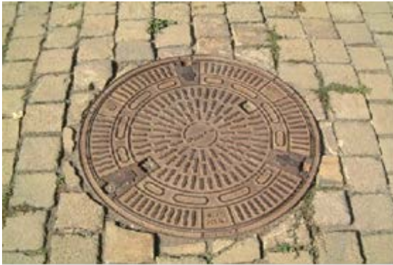
400 Abdeckung Vollguss (ACO drain) → Bauhöhe 16 cm
