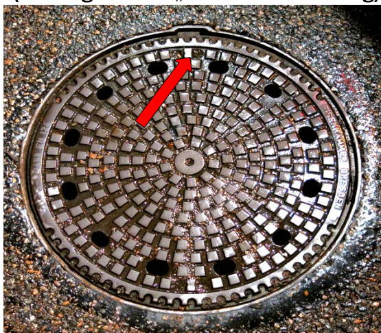
D 400 Abdeckung (flach) Vollguss → Bauhöhe 10 cm
