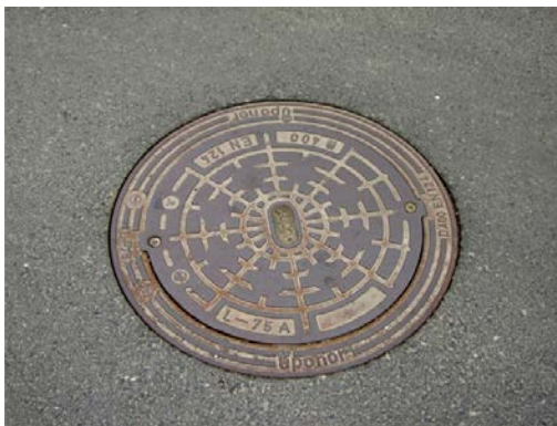
D 400 Abdeckung (Vollguss), Deckeldurchmesser 48,5 cm
