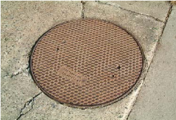
A 15 Abdeckung Kuchendeckel (Vollguss) → Bauhöhe 4 cm
