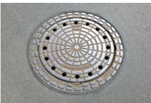
Bild D 55: mit Lüftung
