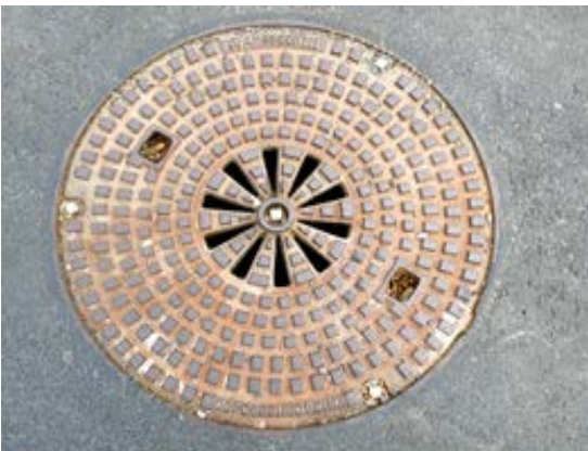
D 400 Drehdeckel DN 600 (Amsbeck) → Bauhöhe 11 cm
