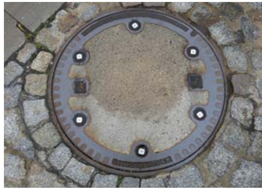
D 400 Abdeckung (tagwasserdicht)
