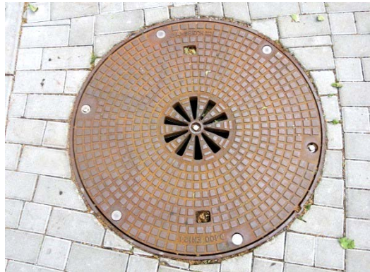
400 Drehdeckel DN 800 (Amsbeck) → Bauhöhe 10,5 cm
