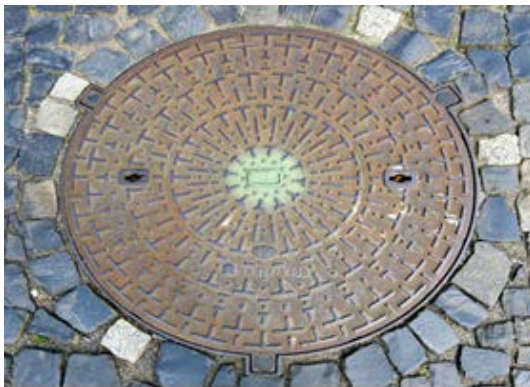
Bild D 65: ohne Lüftung
