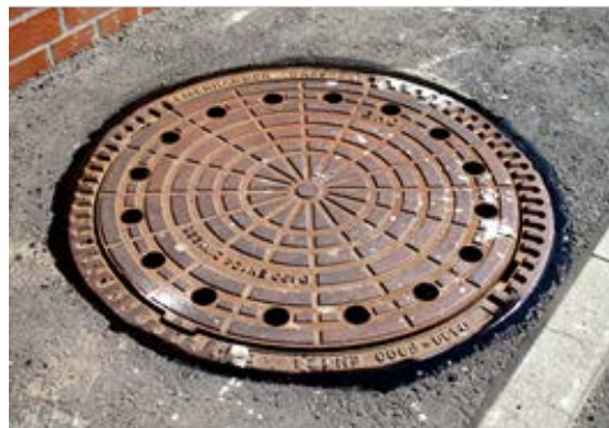
Bild D 52: mit Lüftung
