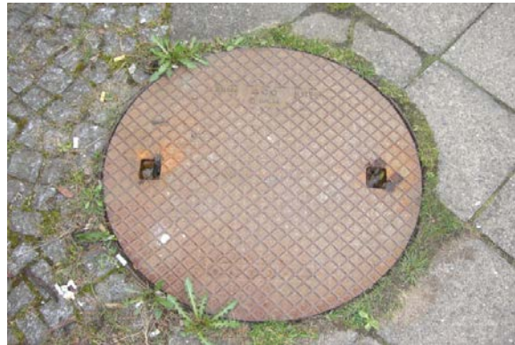
B 125 Abdeckung Vollguss → Bauhöhe 3,5 cm
