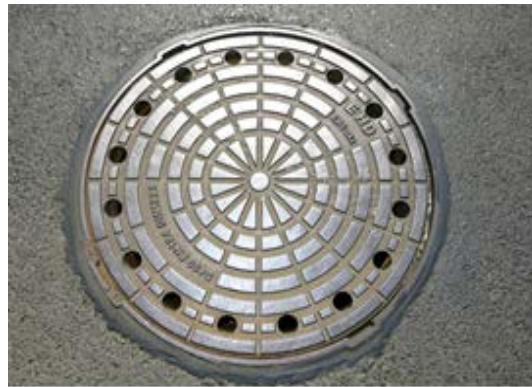
Bild D 54: mit Lüftung
