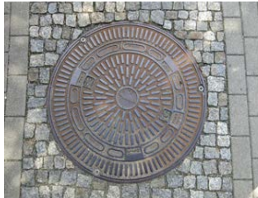
D 400 Abdeckung Vollguss (ACO) verschraubt
