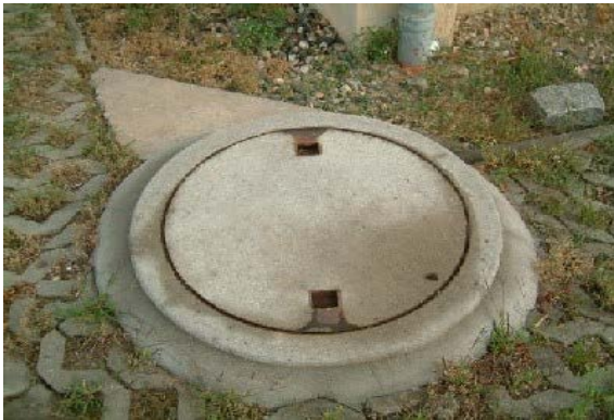
A 15 Abdeckung Beton (Göbel) → Bauhöhe 8 cm
