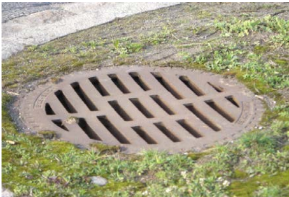
B 125 Abdeckung (Einlaufrost), Deckel Vollguss, BEGU-Rahmen → Bauhöhe 12,5 cm
