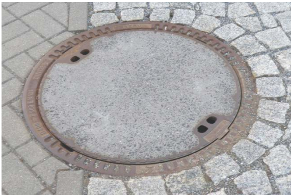
Bild D 6g: ohne Lüftung
