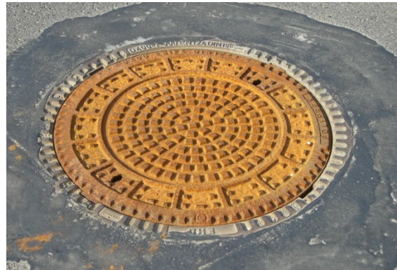
Bild D 1b: ohne Lüftung
