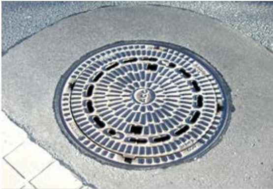
D 400 Abdeckung Vollguss Multitop (Aco) → Bauhöhe 14 cm
