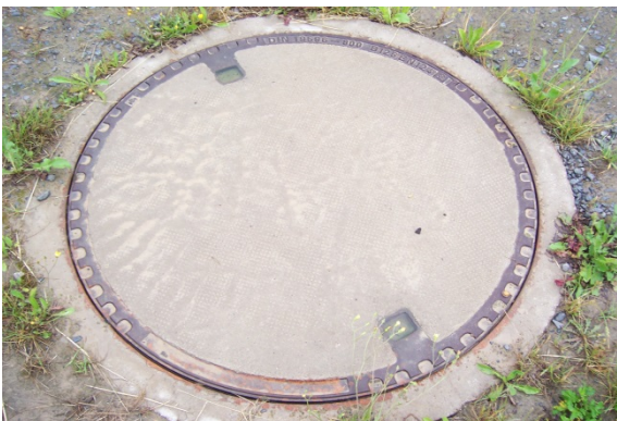
B 125 Abdeckung BEGU Deckel/Rahmen → Bauhöhe 12 cm - Lichte Weite 800mm -
