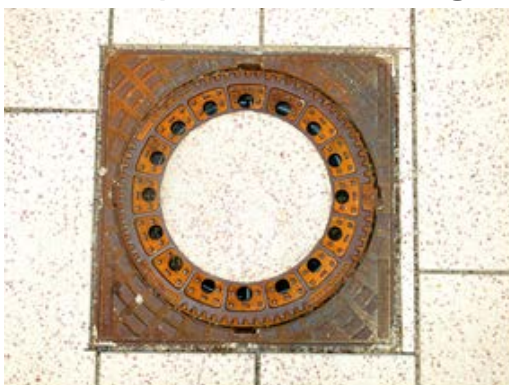
D 400 Abdeckung (auspflasterbar) → Bauhöhe 16 cm
