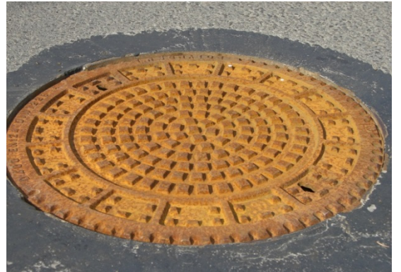
Bild D 2b: ohne Lüftung
