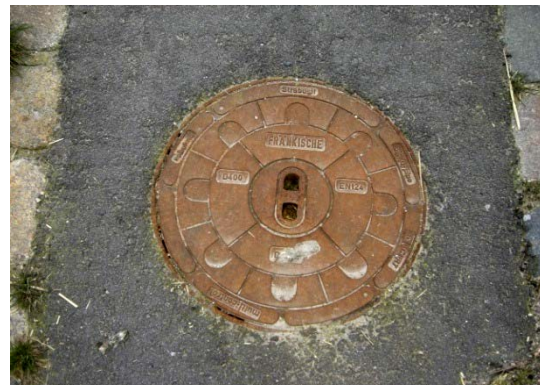
400 Abdeckung (Vollguss), Deckeldurchmesser 48,5 cm
