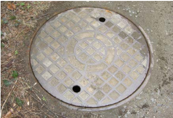
A 15 Abdeckung Vollguss, Deckeldurchmesser 68 cm → Bauhöhe 8 cm
