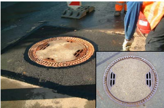
Bild D 6e: mit Lüftung
