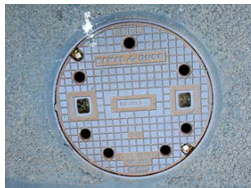
D 400 Abdeckung (Romold) DN 500 → Bauhöhe 11 cm
