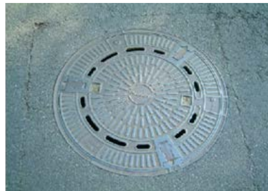
Bild D 26a: mit Lüftung
