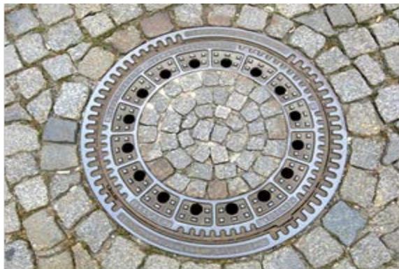
D400 Abdeckung (auspflasterbar) → Bauhöhe 16 cm
