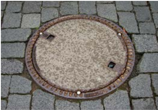
D 400 Abdeckung (tagwasserdicht) → Bauhöhe 16 cm
