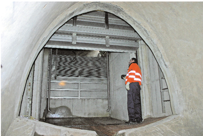
Abbildung 9: Regelorgan Schaufuß- straße – Absenktechnik mit Siebrechenanlage
