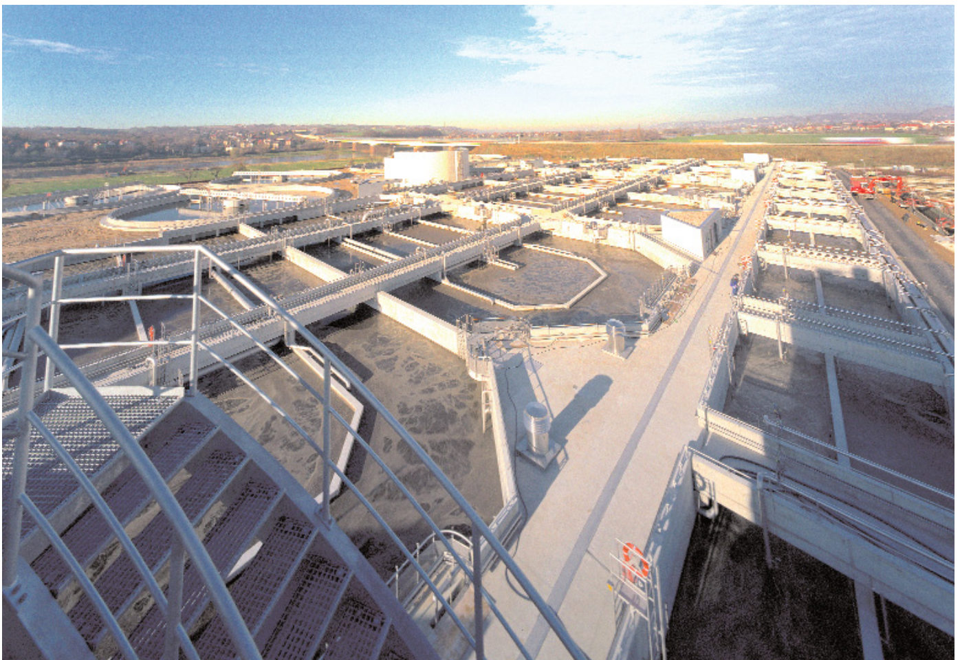
Abbildung 24: Neue biologische Reinigungsstufe der Kläranlage Kaditz
