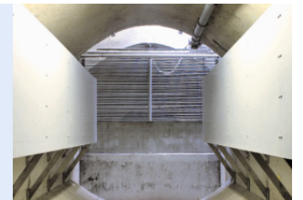
2 Steuerbauwerk Ballhaus Watzke
